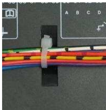
С правильно размещенным кабелем и стяжкой
